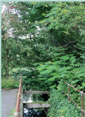
Det tekniske anlæg på nabogrunden
