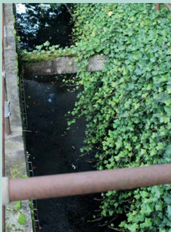
Regnvand i det tekniske anlæg
