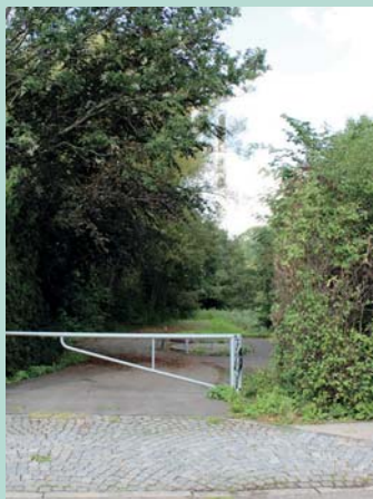
Indgang til teknisk anlæg
